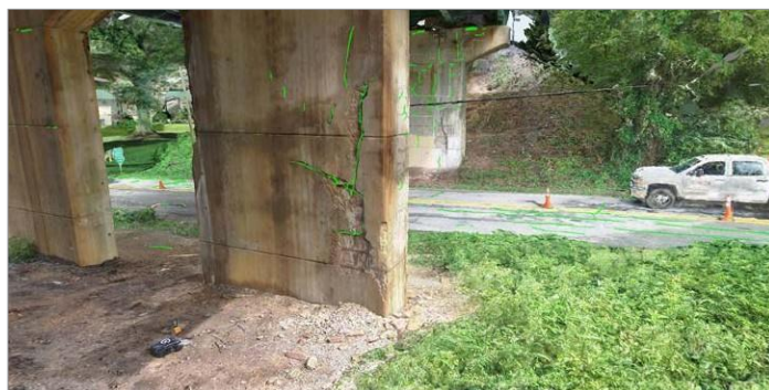
Tirez parti de l'apprentissage automatique pour détecter automatiquement les défauts affectant l'infrastructure, tels que les fissures ou l'écaillage, afin de prendre en charge les tâches d'inspection. Image reproduite avec l'aimable autorisation de West Virginia DOT.
